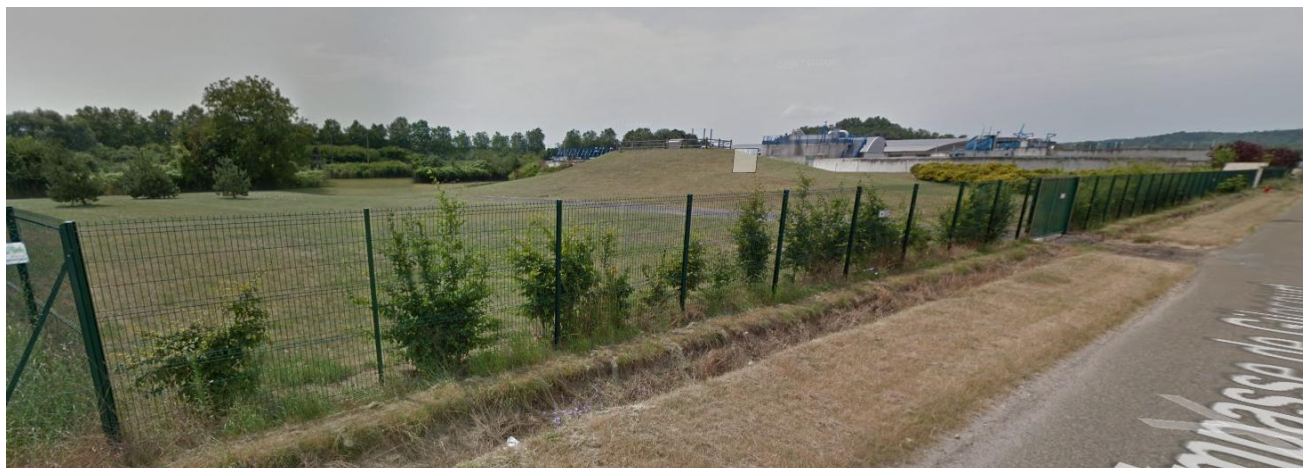
Figure 52: Intégration paysagère de la station d'épuration
